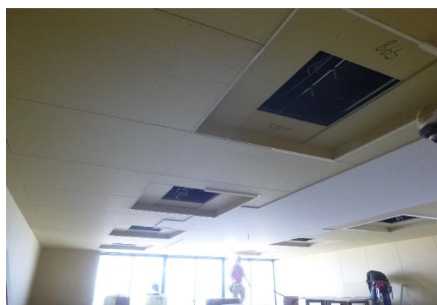
■ 5階室内仕上状況
