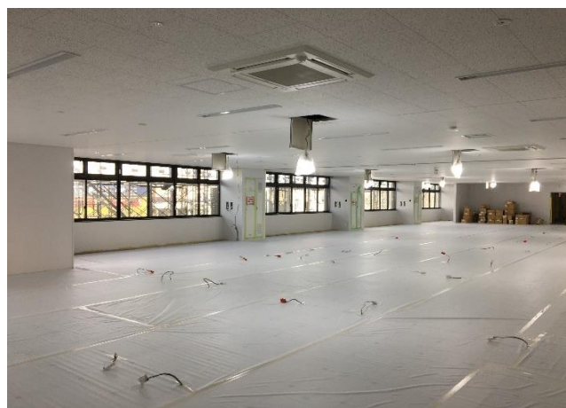
■ 2階室内仕上状況
