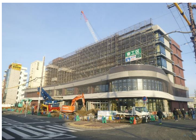
■ 工事進捗状況(全景)
