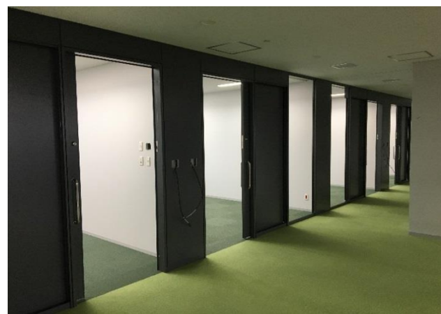
■4階室内仕上状況
