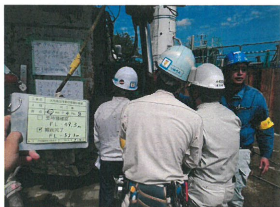
■掘削深さ、支持層確認状況
