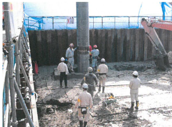
■杭建込み状況
