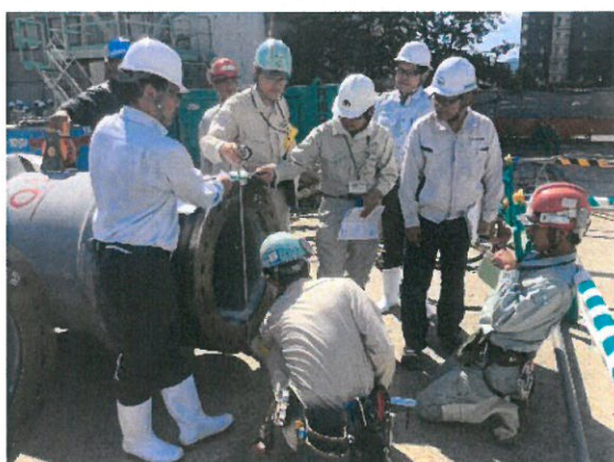
■試験杭立会い状況
