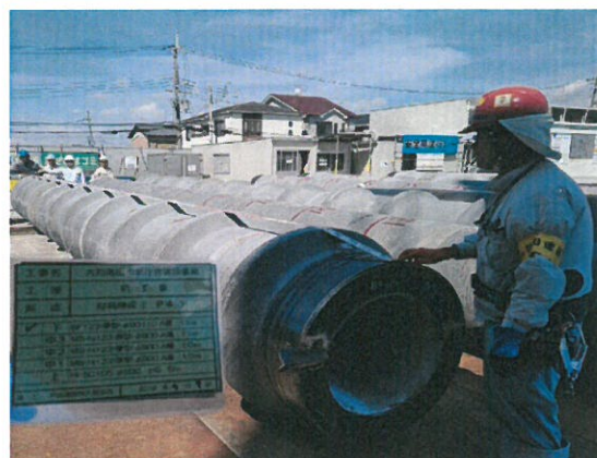
■杭受入検査状況
