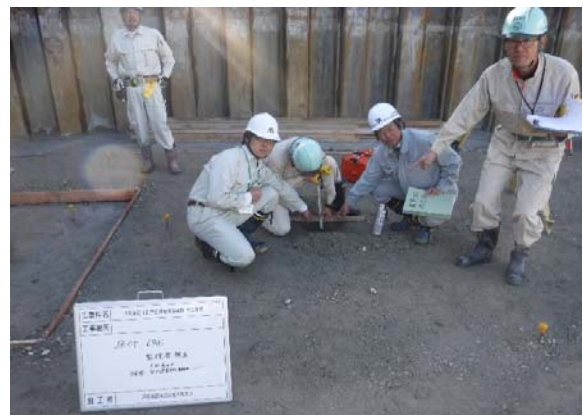
■ 掘削床付け立会検査状況(②砕石厚さ)
