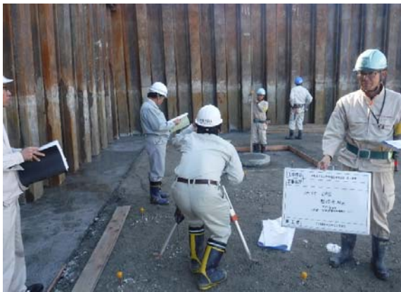
■ 杭高さ立会検査状況(①掘削深さ)
