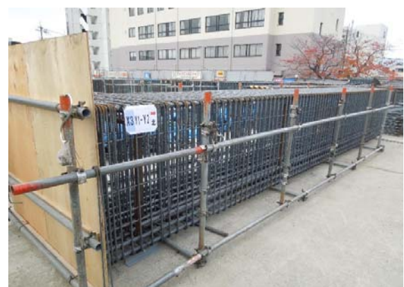
■ 基礎梁配筋状況
