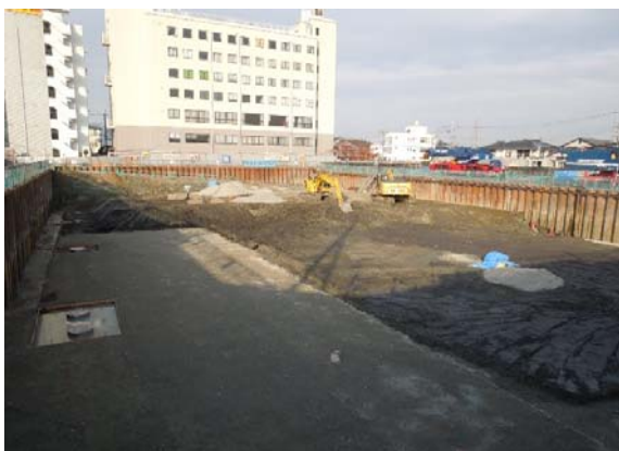
■ 掘削状況(全景:南東より)
