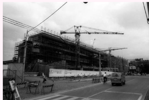
オークタウン建設中(昭和50年)
