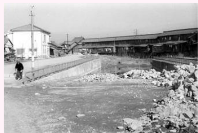
昭和33年頃 工事中的様子
