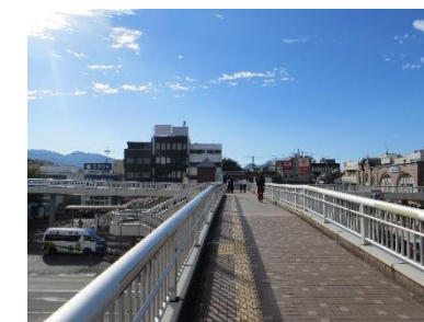
近鉄大和高田駅前フラワーデッキ
