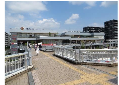
近鉄大和高田駅前フラワーデッキ
