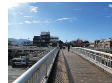
近鉄大和高田駅前フラワーデッキ
