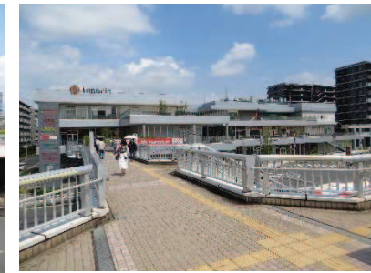
近鉄大和高田駅前フラワーデッキ
