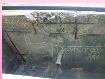
床版の損傷（鉄筋露出）
