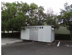
■大和高田市総合公園の防災倉庫
