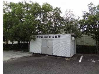
■ 防災倉庫 （大和高田市総合公園）
