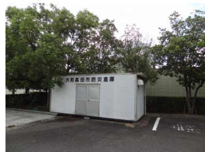
■大和高田市総合公園の防災倉庫
