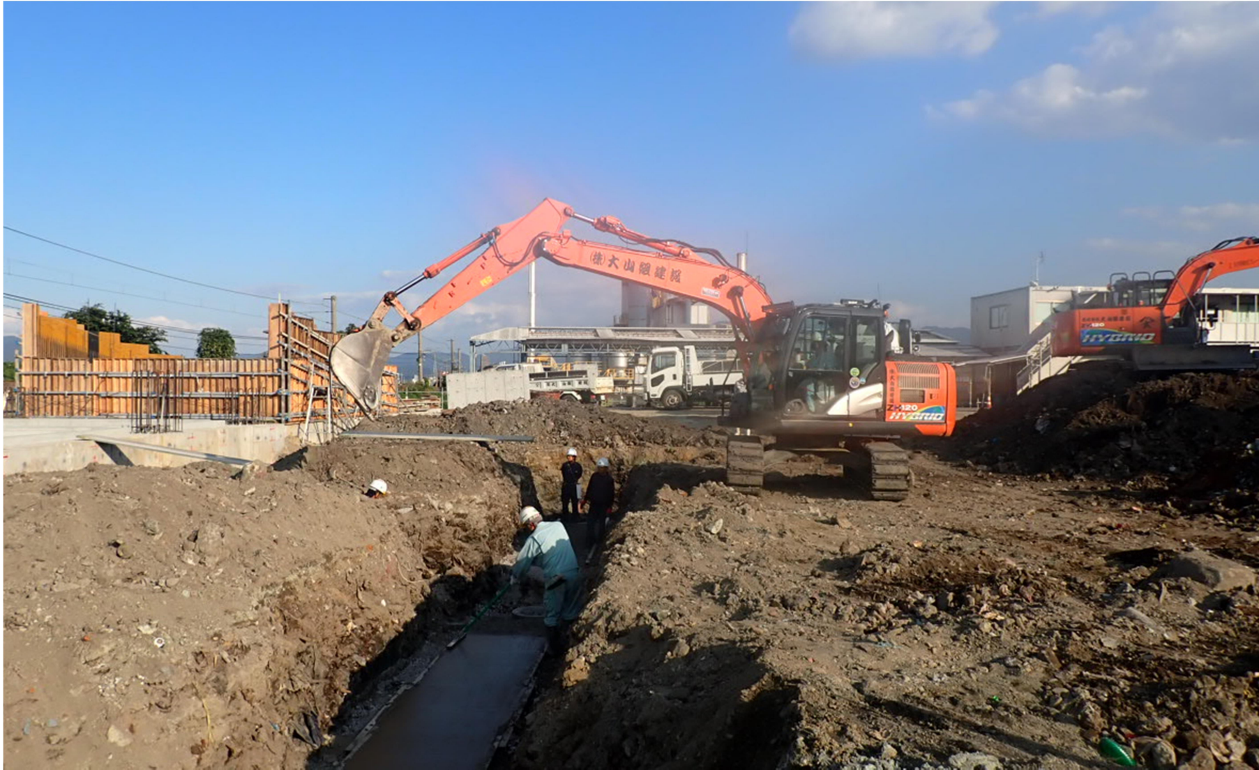
工事状況写真（掘削工事 2階建て駐車場）
