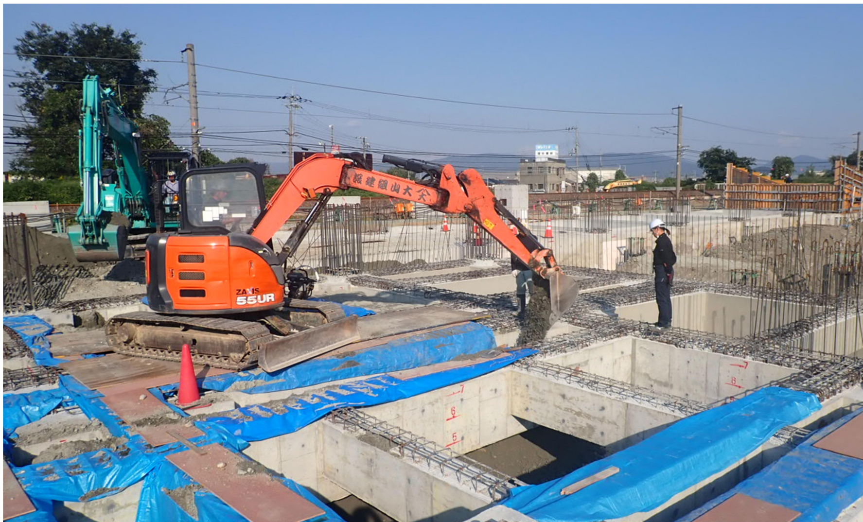
工事状況写真（基礎埋戻し 中継棟）
