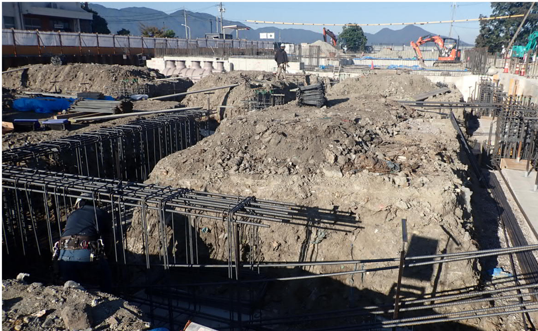
工事状況写真（配筋工事 2階建て駐車場）
