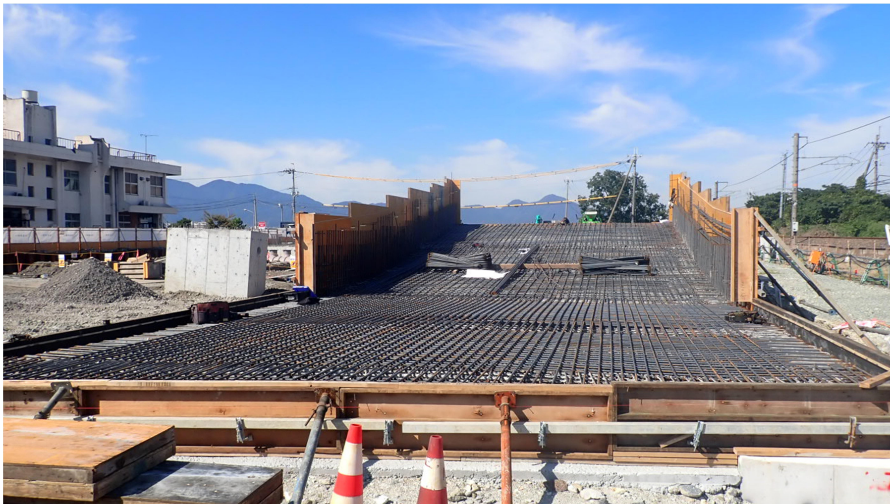
工事状況写真（配筋工事 ランプウェイ）
