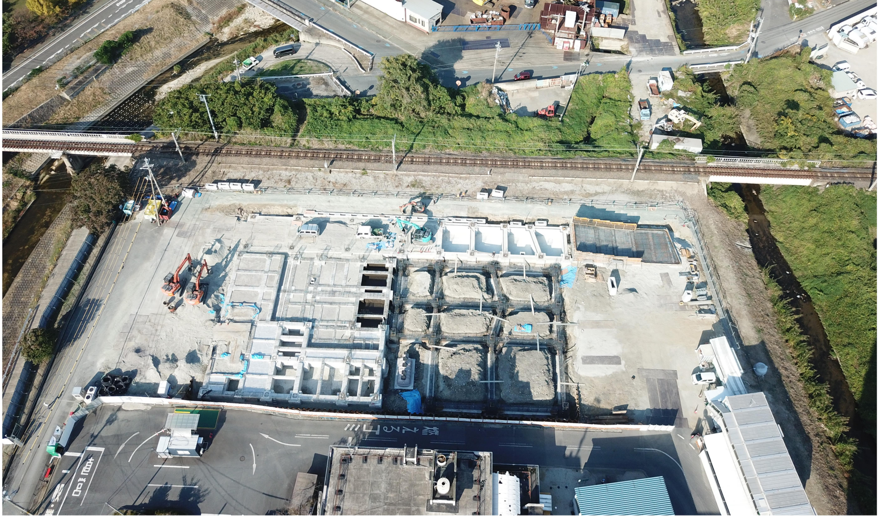
工事状況写真（全景）
