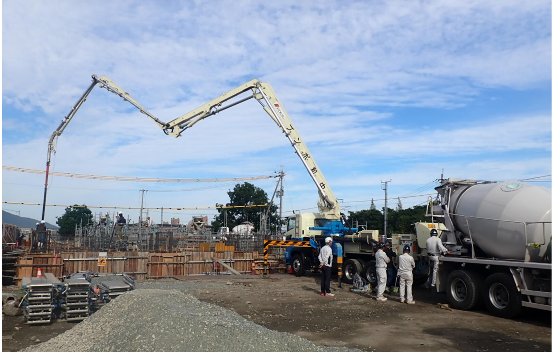
工事状況写真（コンクリート打設工事 中継棟）
