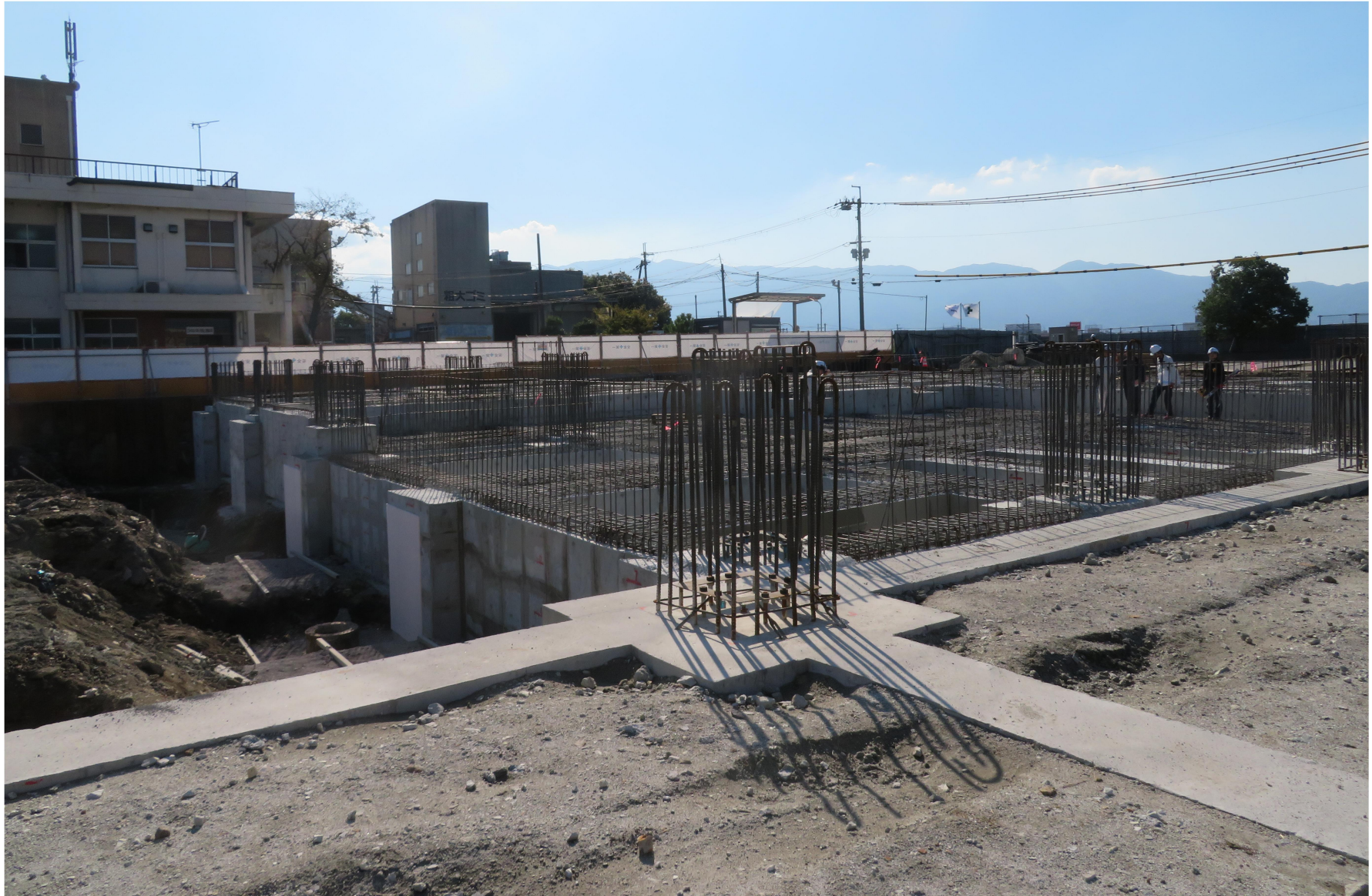
工事状況写真 (型枠脱型 中継棟)
