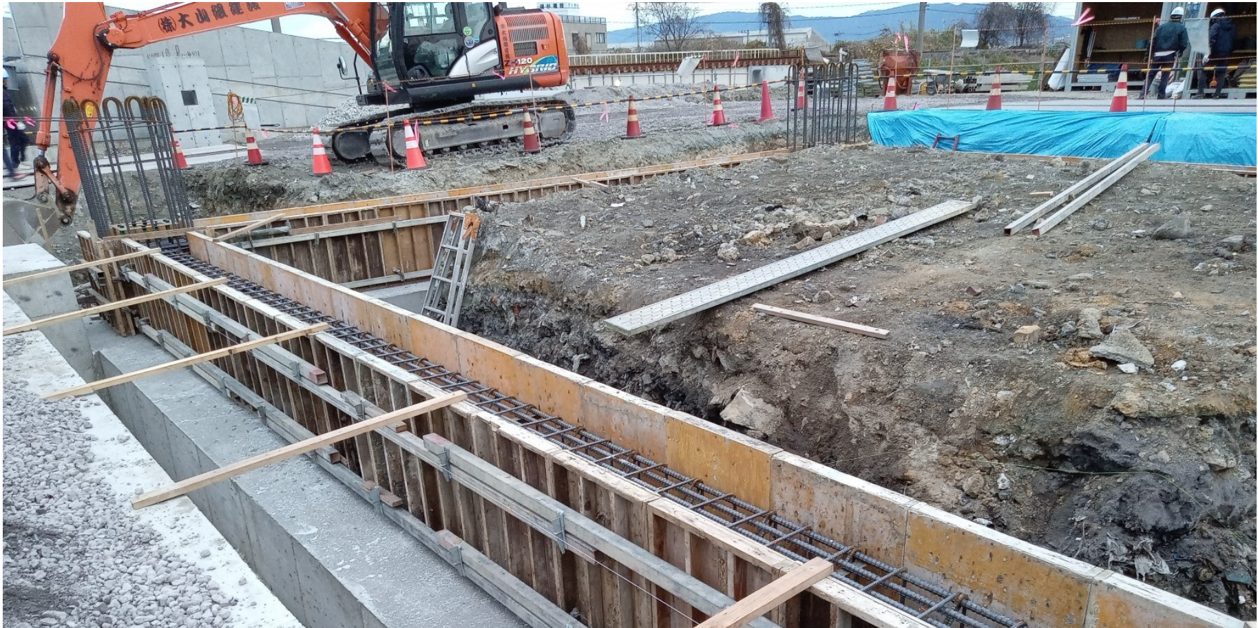
工事状況写真 (型枠工事 平屋駐車場)
