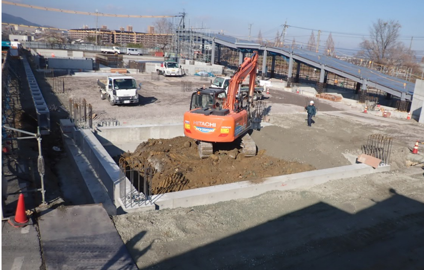
工事状況写真（基礎工事 平屋駐車場）
