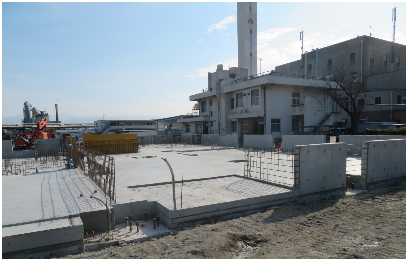
工事状況写真 (型枠脱型 中継棟)
