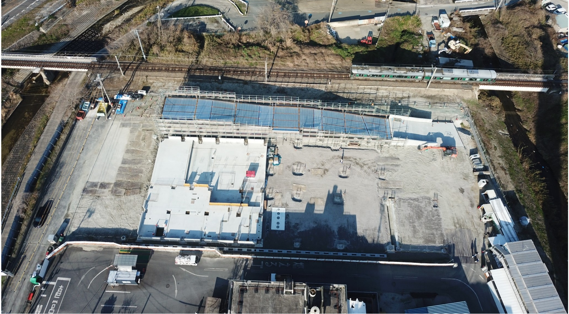
工事状況写真（全景）
