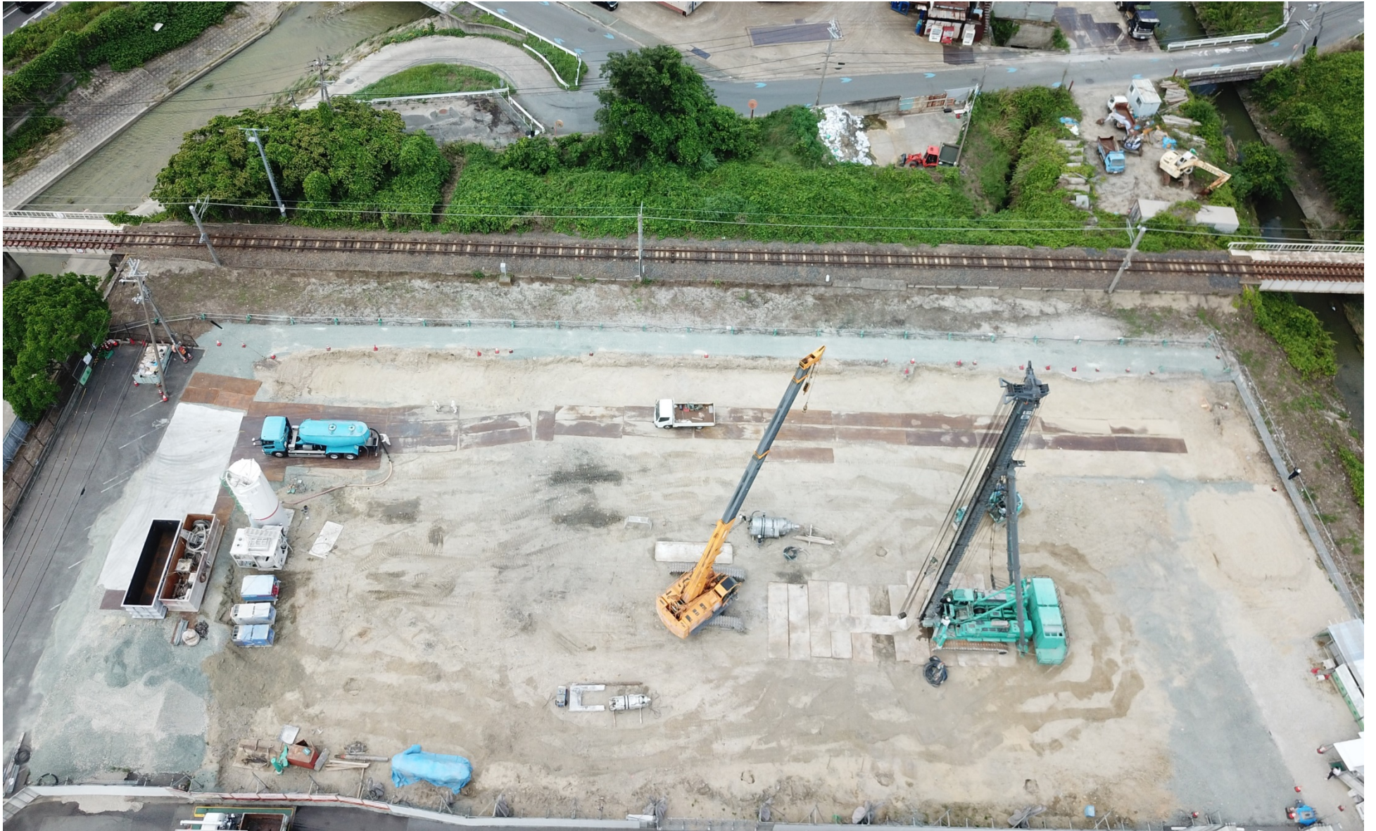
工事状況写真（全景）
