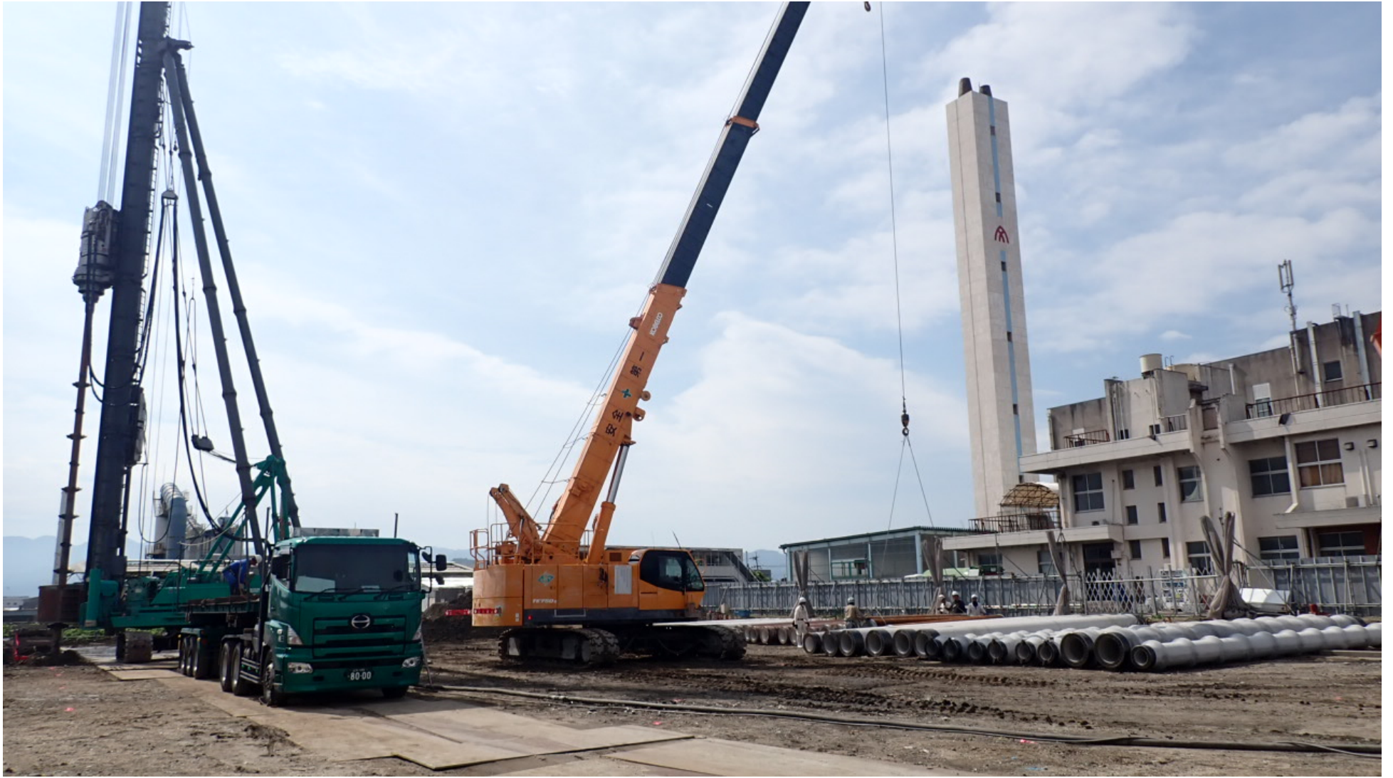
工事状況写真（杭工事）
