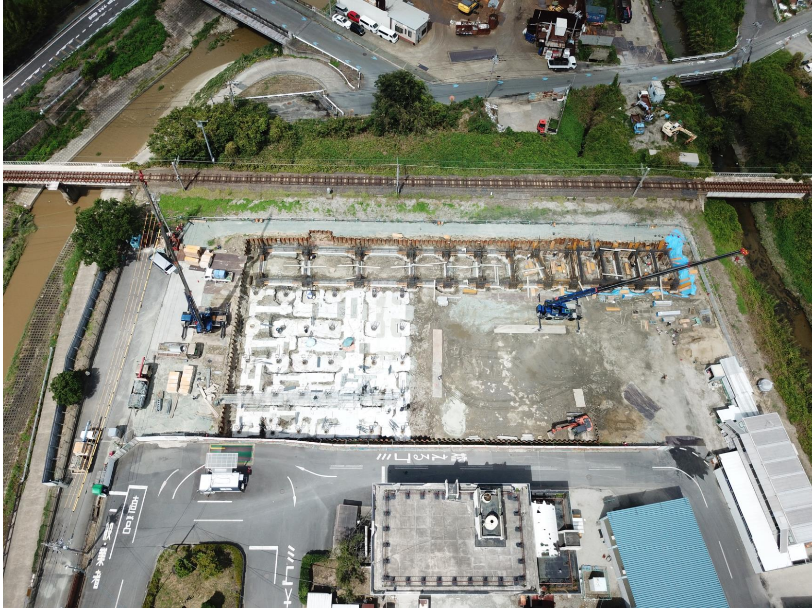
工事状況写真（全景）
