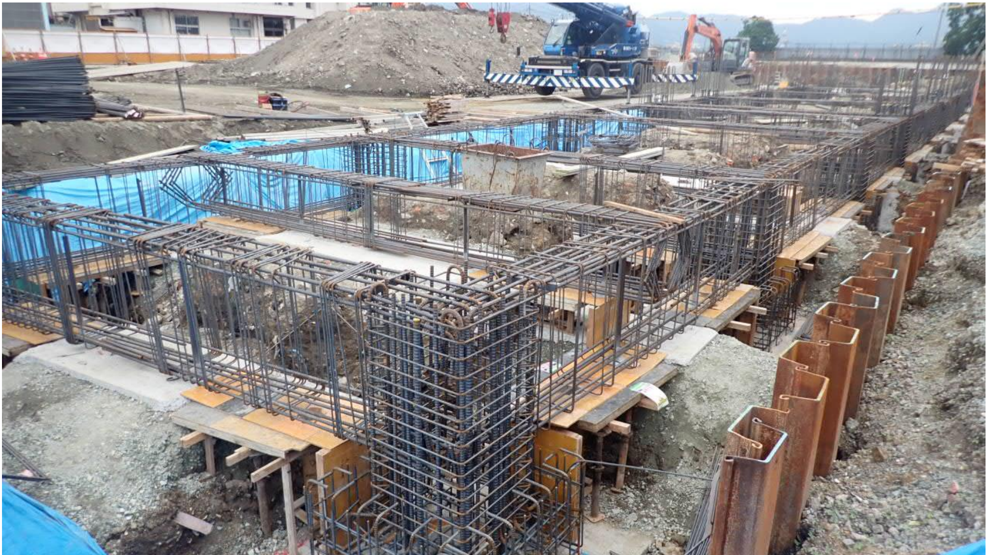
工事状況写真（配筋工事 ランプウェイ）
