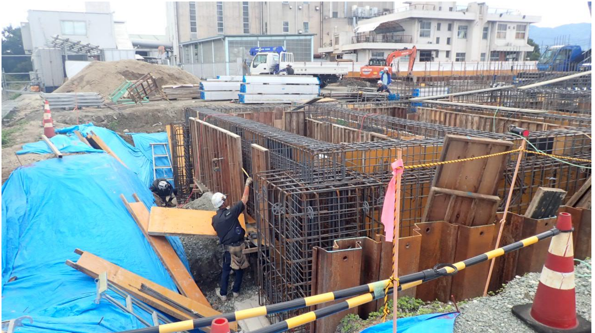
工事状況写真（型枠工事 ランプウェイ）
