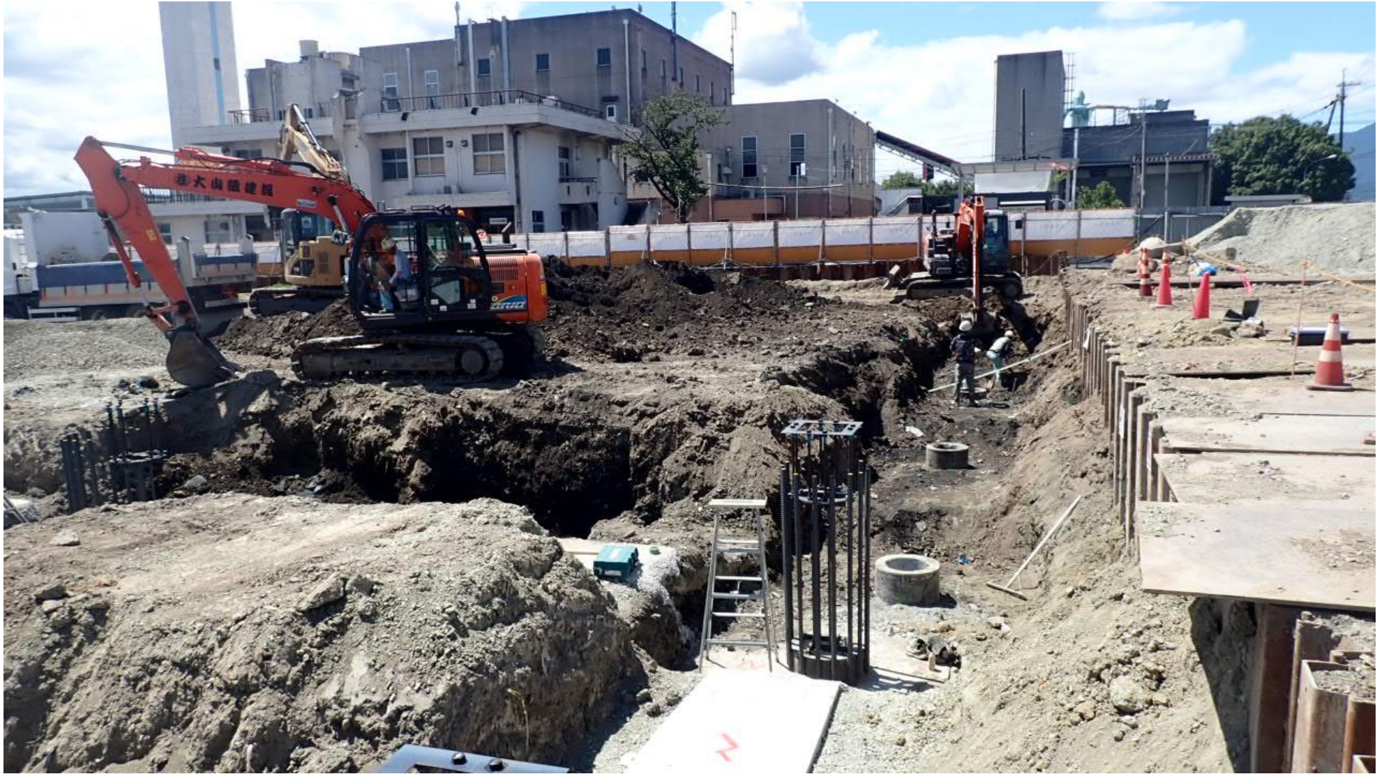
工事状況写真（掘削工事 中継棟）
