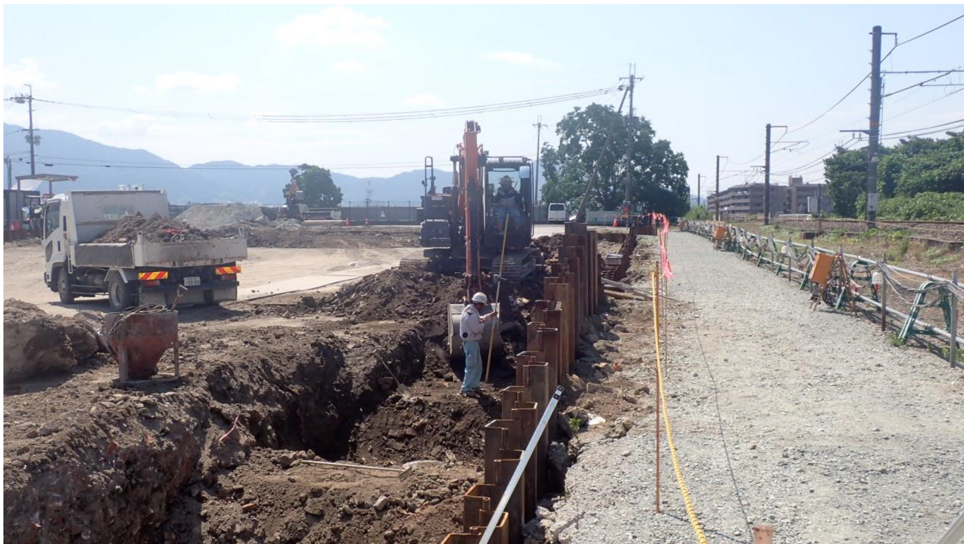
工事状況写真（掘削工事 ランプウェイ）
