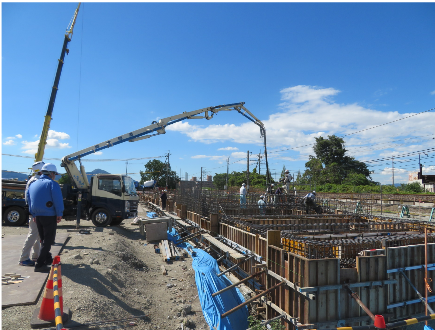
工事状況写真（コンクリート打設工事 ランプウェイ）
