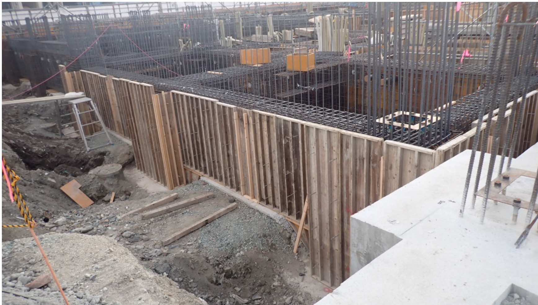
工事状況写真 (型枠工事 中継棟)
