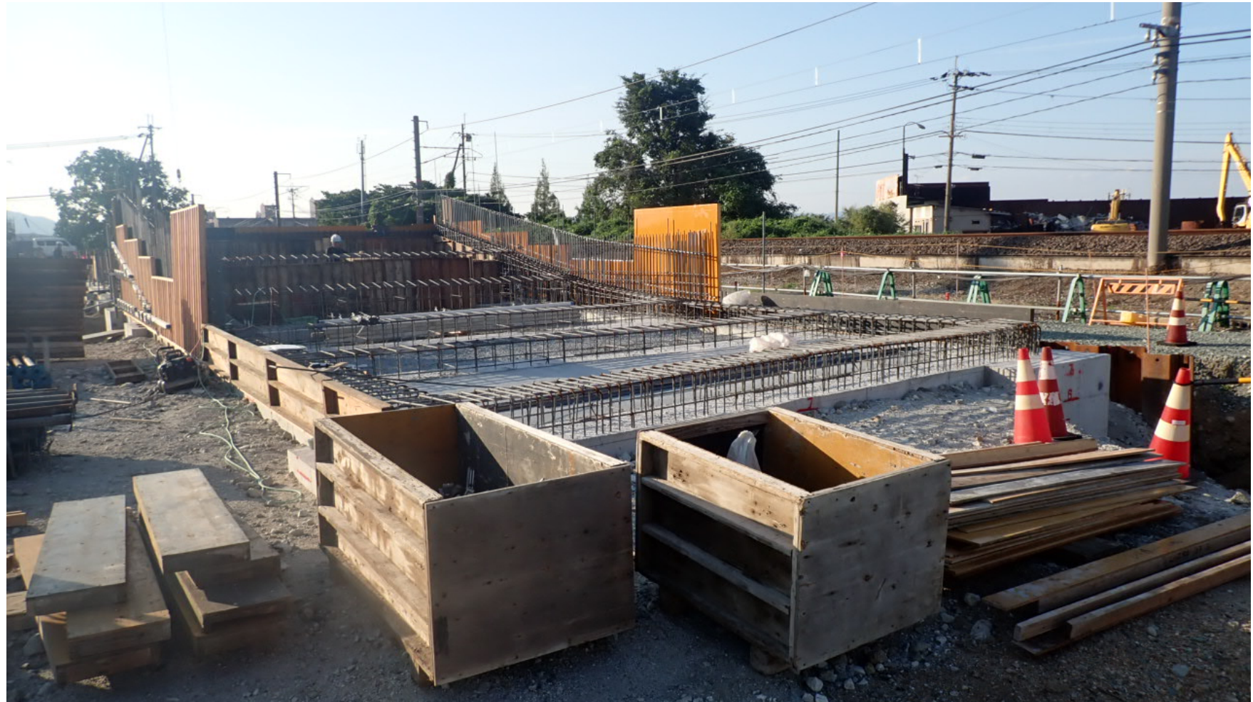
工事状況写真（スロープ RC 部型枠工事 ランプウェイ）
