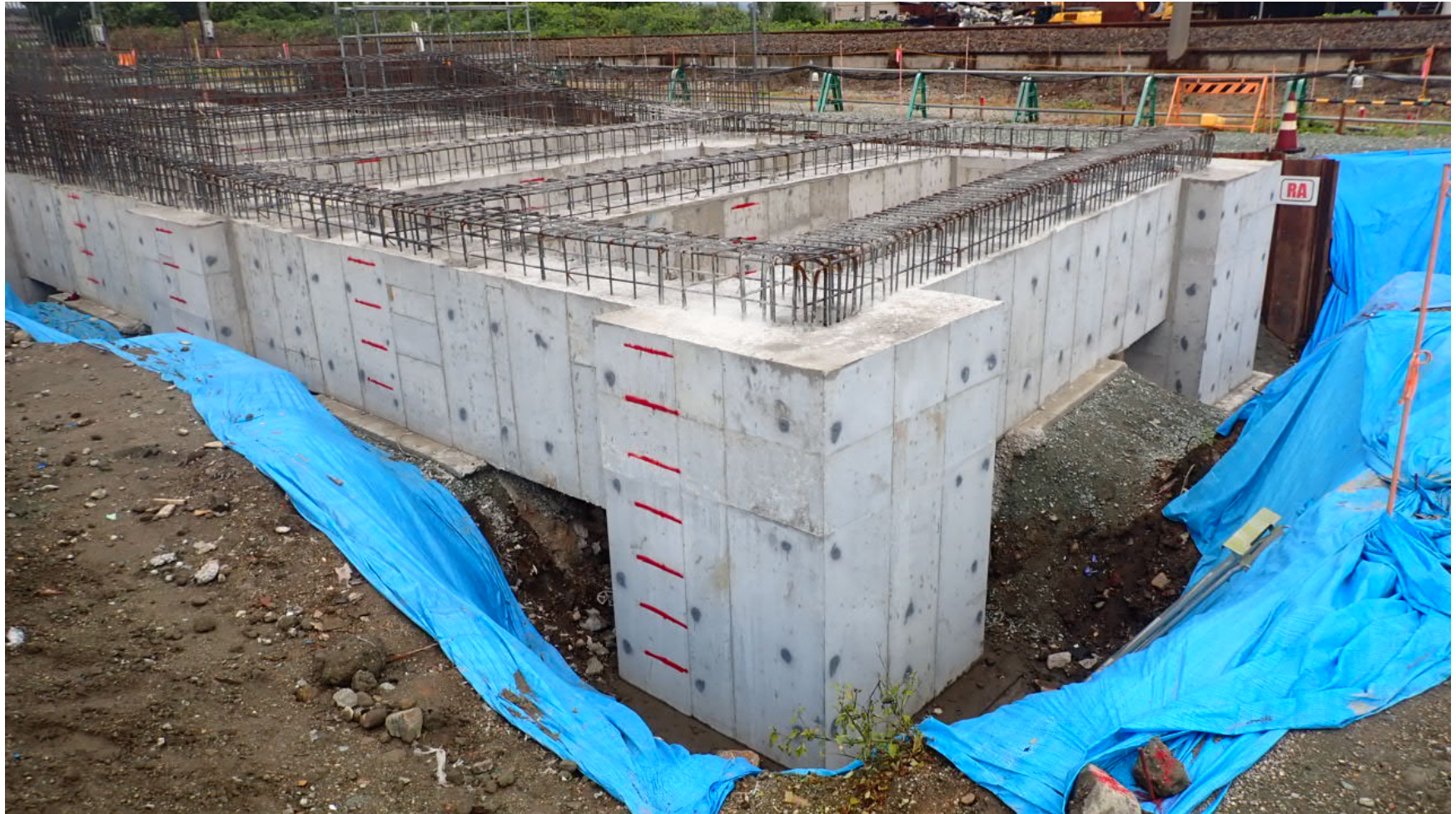
工事状況写真（型枠脱型 ランプウェイ）
