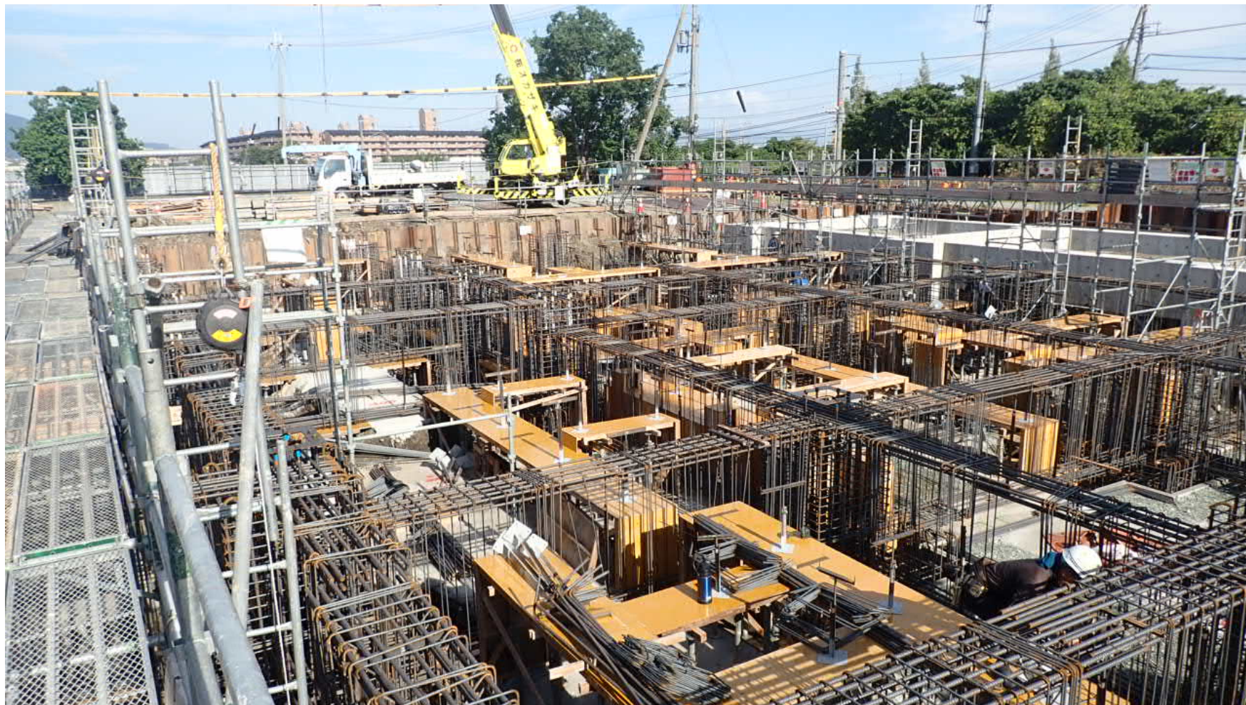
工事状況写真（配筋工事 中継棟）
