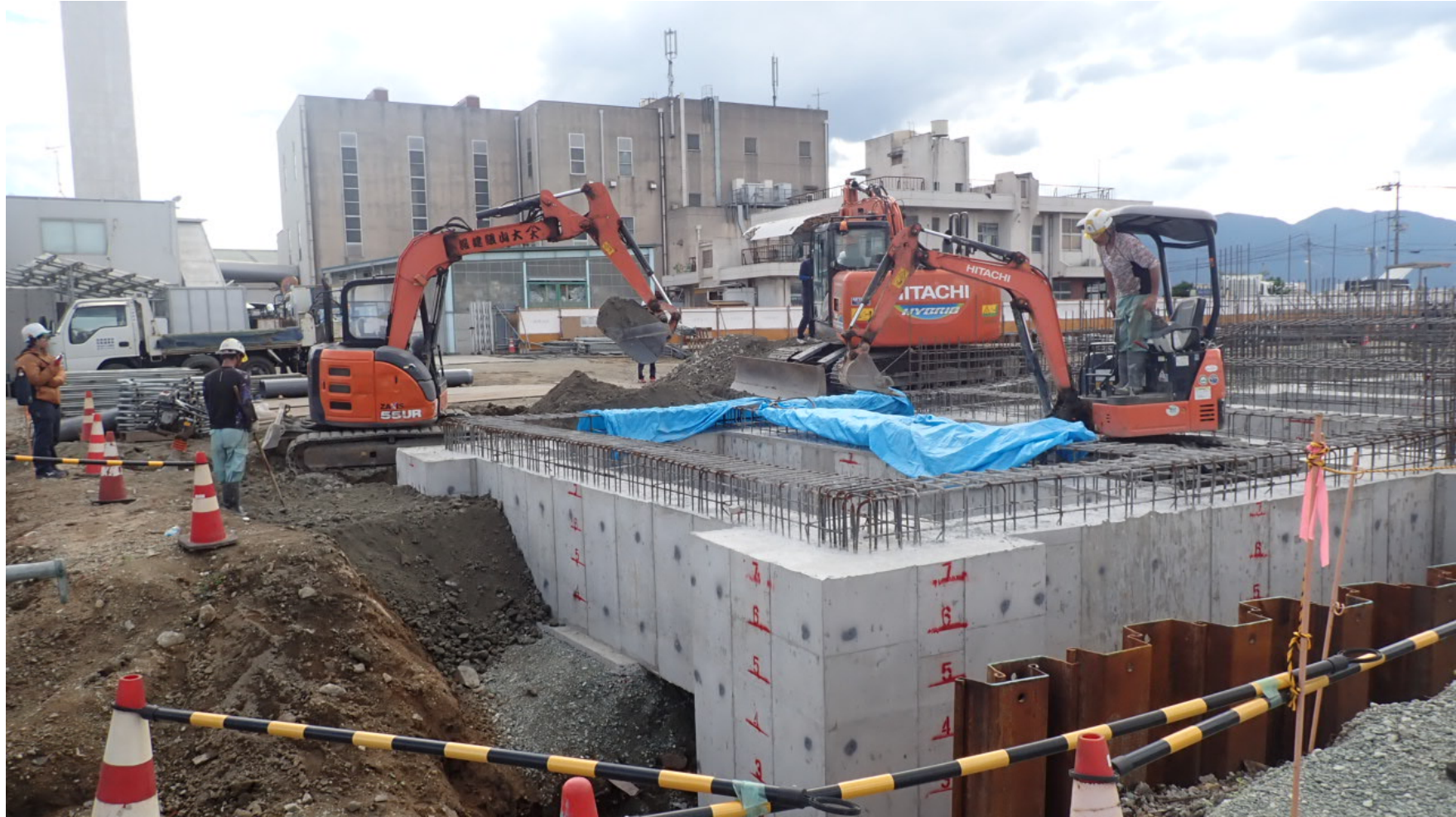
工事状況写真（基礎埋戻し ランプウェイ）
