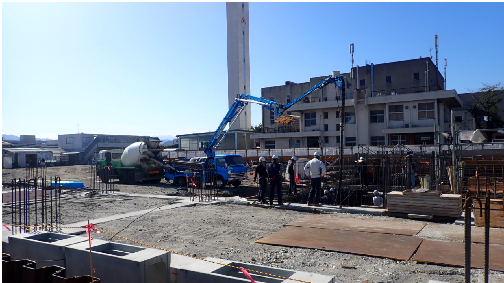
工事状況写真（ピット耐圧盤コンクリート打設工事 中継棟）
