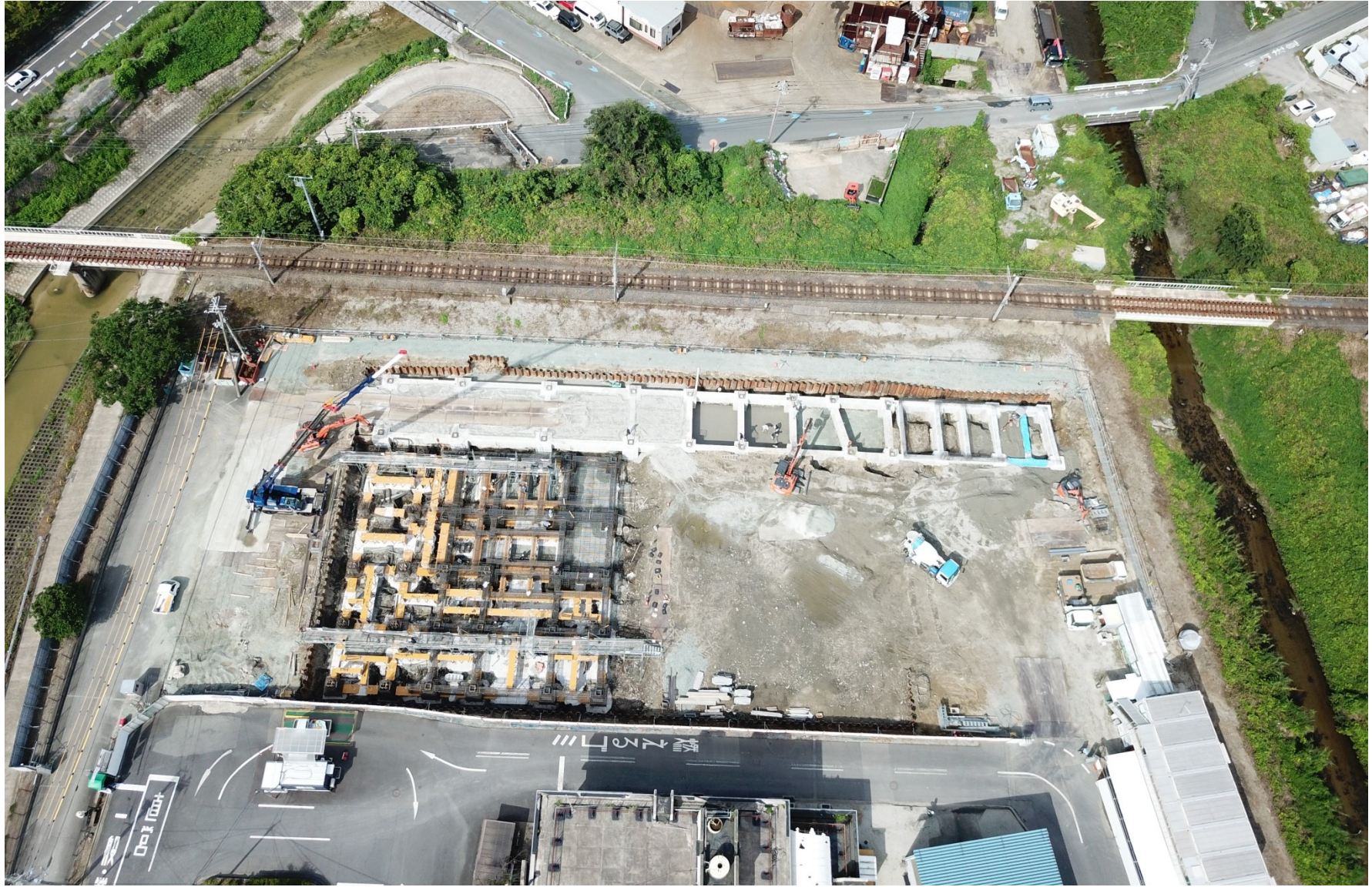
工事状況写真（全景）
