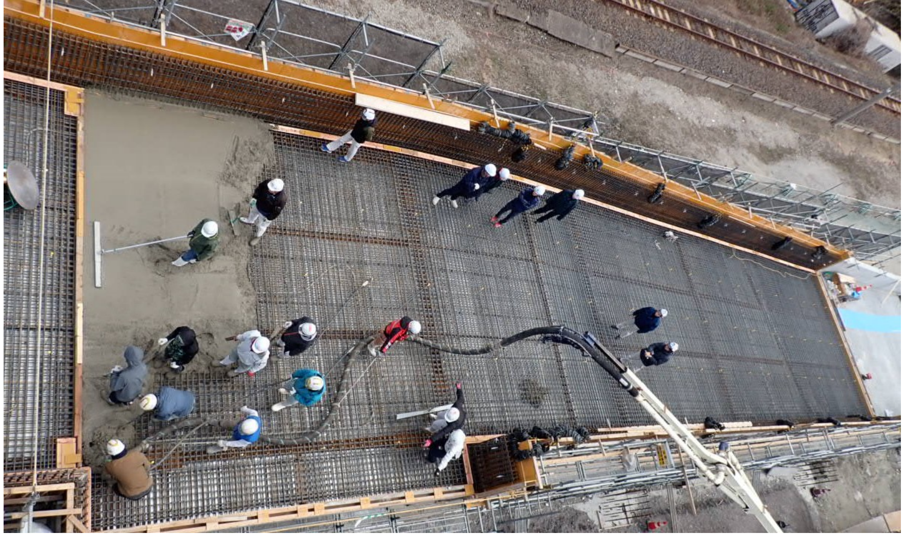
工事状況写真（コンクリート打設工事 ランプウェイ）
