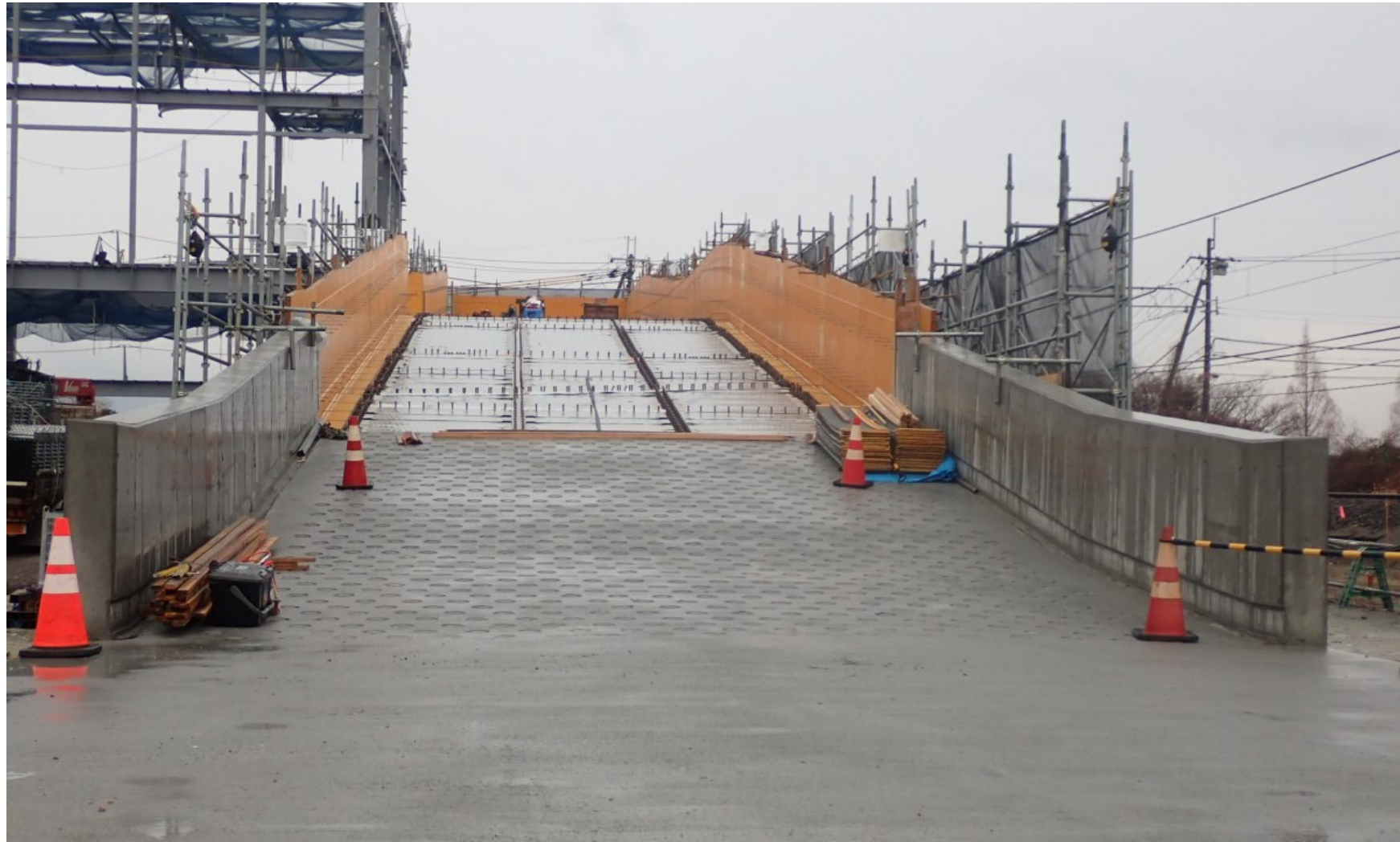
工事状況写真（腰壁外壁組立 ランプウェイ）
