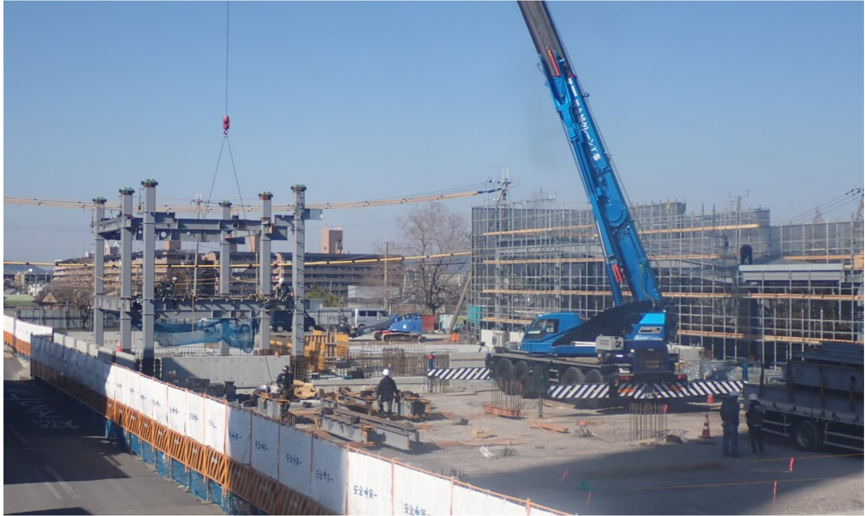
工事状況写真（鉄骨建方 中継棟）
