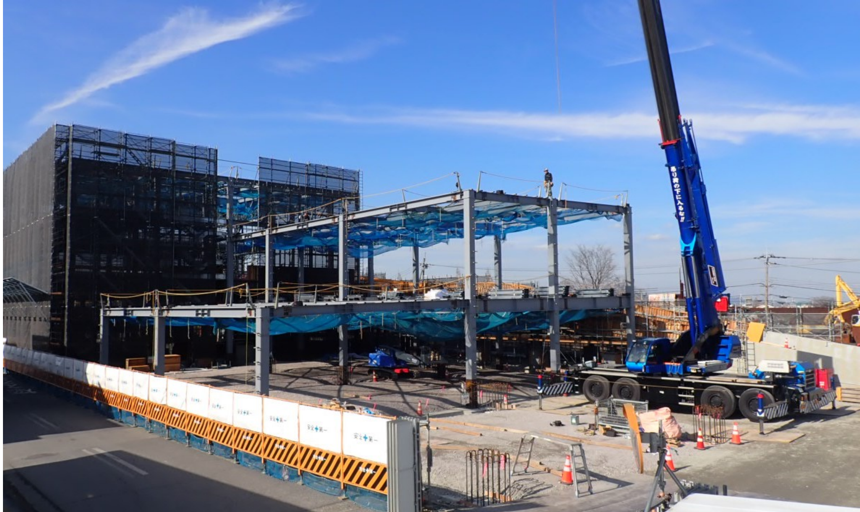
工事状況写真（鉄骨建方 2階建て駐車場）
