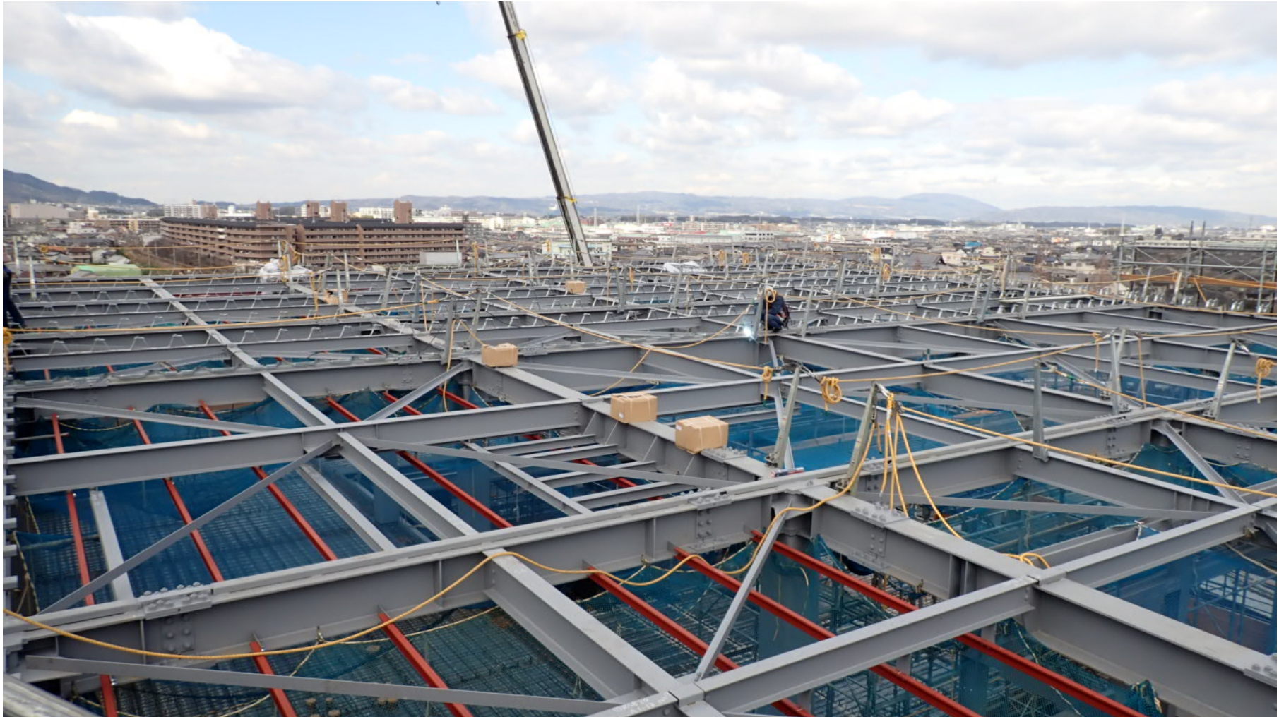
工事状況写真（タイトフレーム取付 中継棟）
