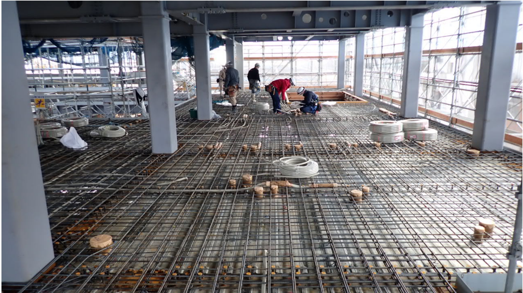
工事状況写真（各階スラブ配筋工事 中継棟）
