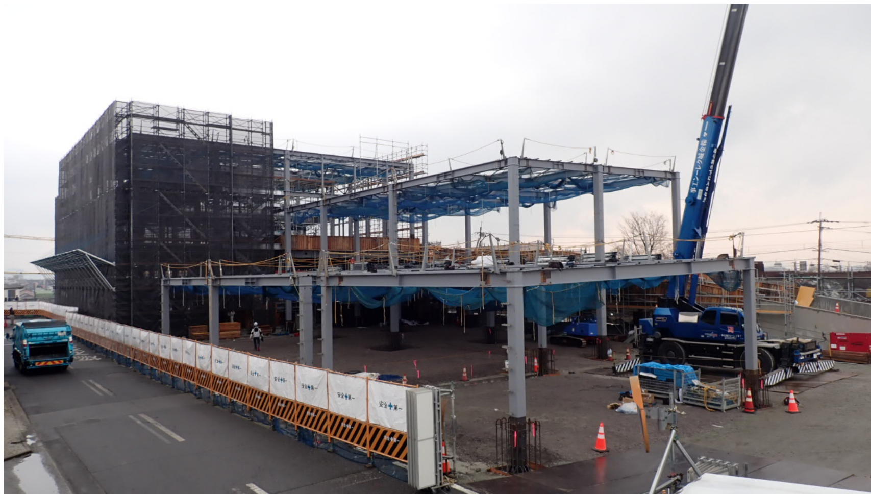
工事状況写真（鉄骨建方 平屋駐車場）
