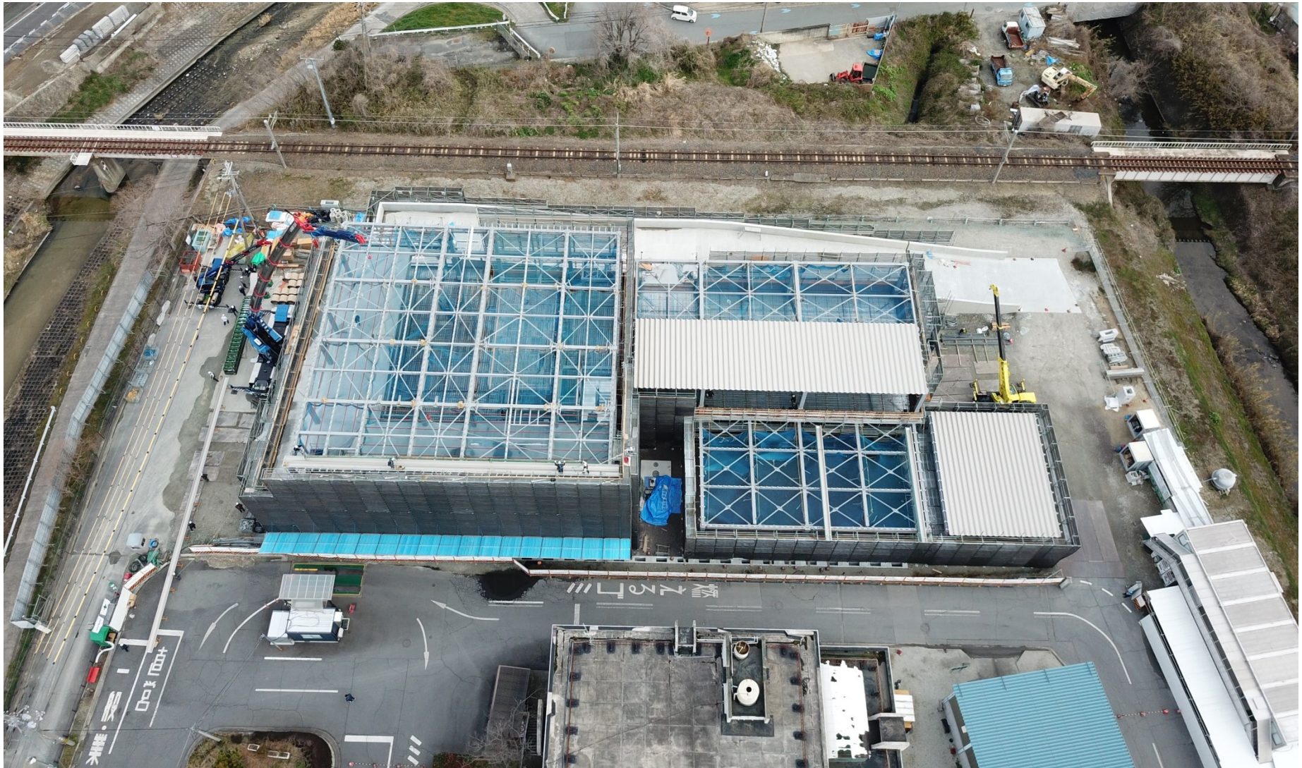
工事状況写真（全景）
