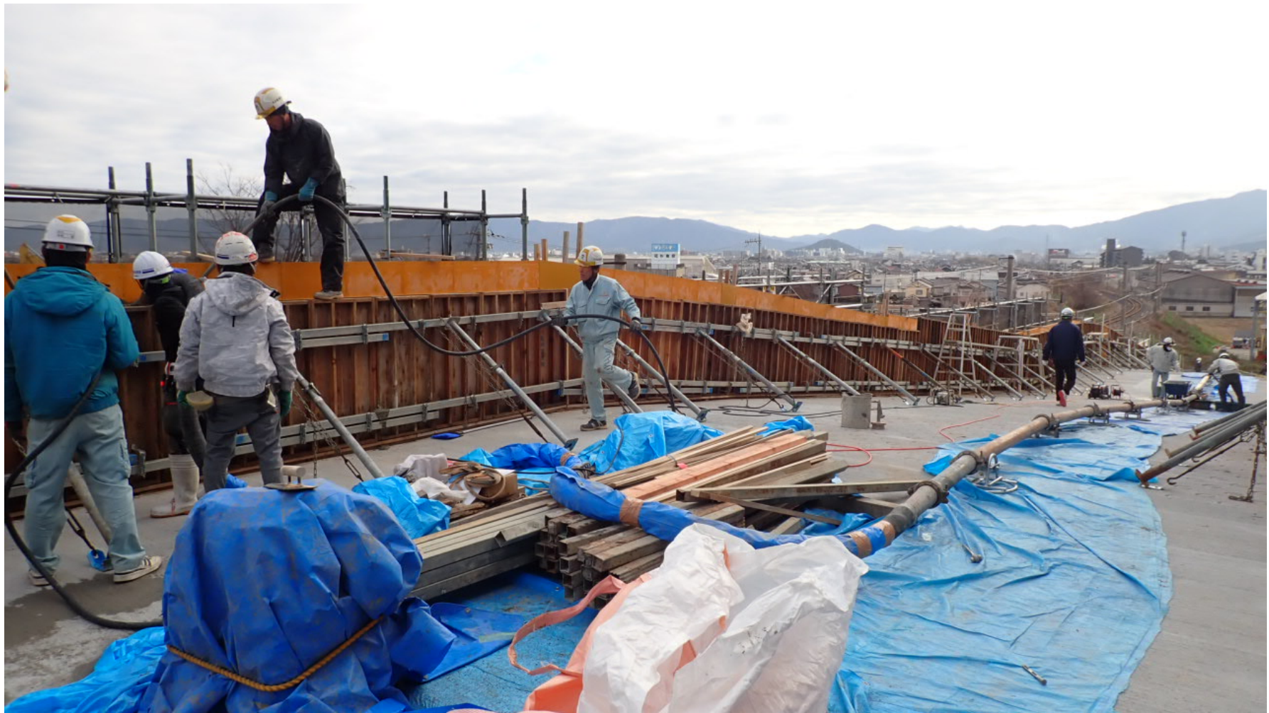
工事状況写真（腰壁コンクリート打設工事 ランプウェイ）
