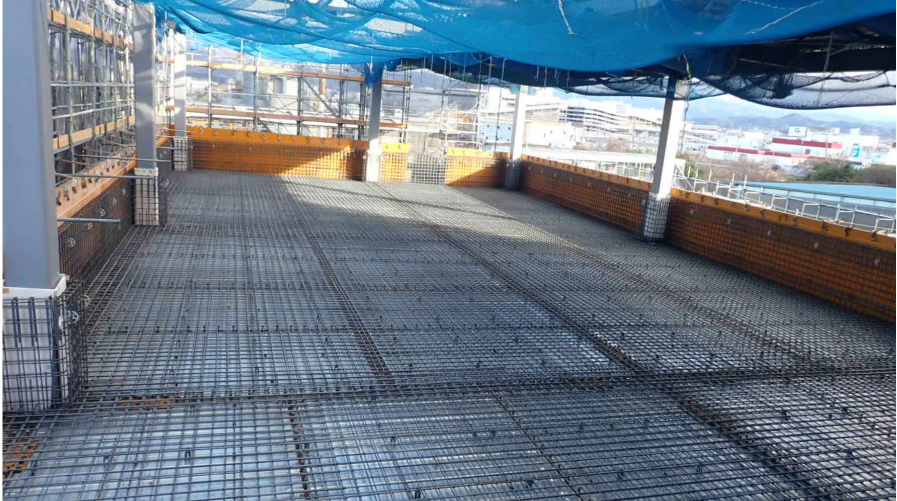
工事状況写真（2F スラブ配筋工事 2階建て駐車場）
