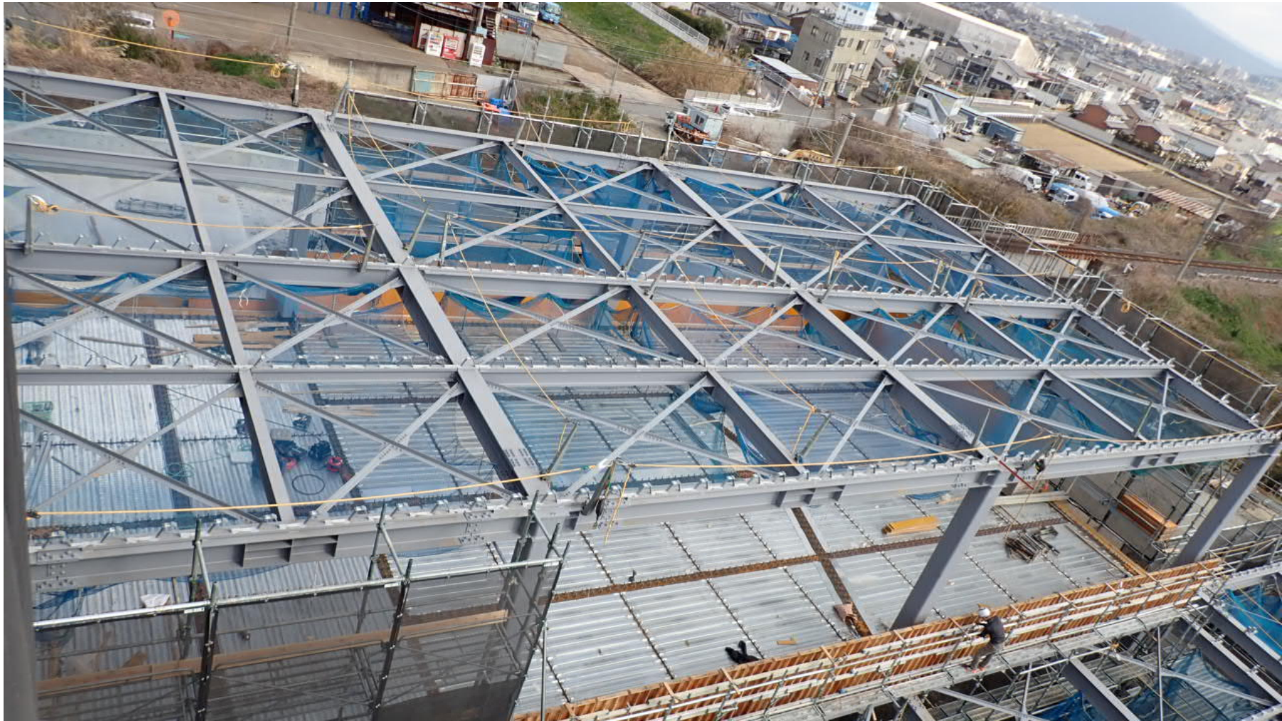
工事状況写真（タイトフレーム取付 2階建て駐車場）
