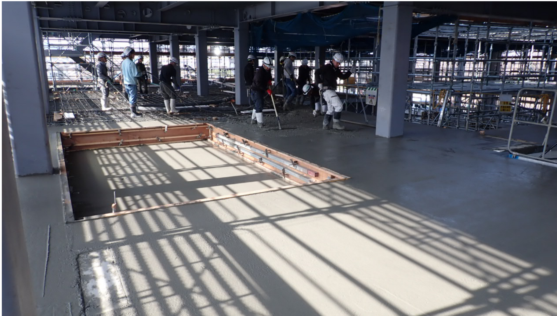
工事状況写真（各階スラブコンクリート打設工事 中継棟）
