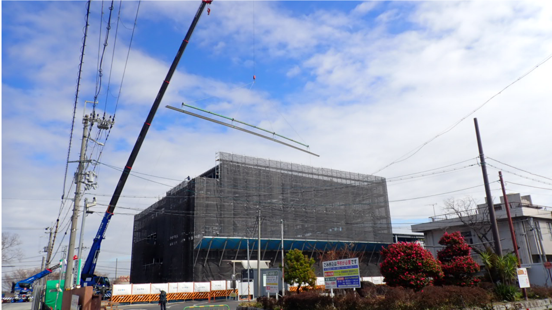
工事状況写真（屋根折版葺き 中継棟）
