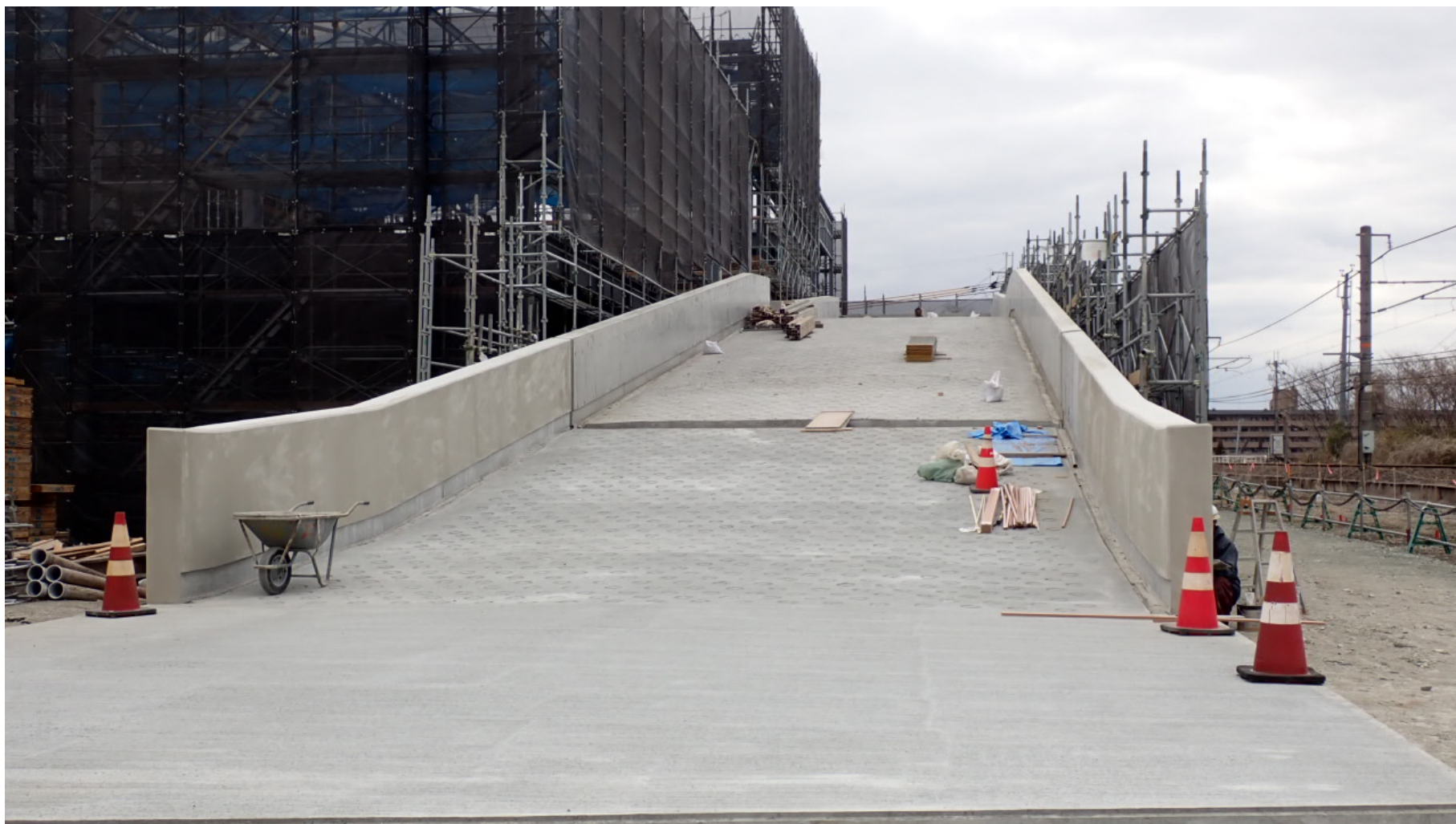
工事状況写真（型枠脱型 ランプウェイ）
