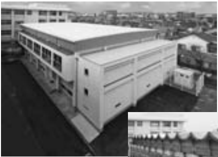
浮孔小学校体育館 耐震工事 平成24年12月完成
