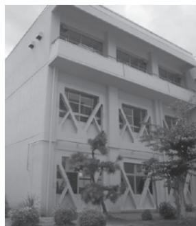
高田中学校の耐震補強
