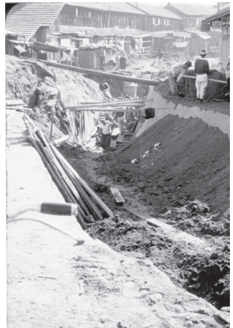
高田川の付け替え工事(昭和26年)
