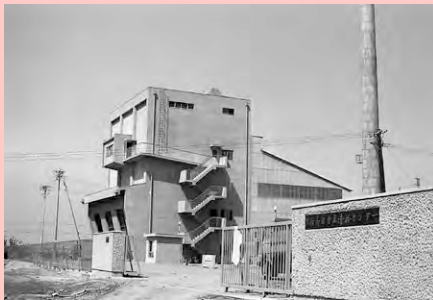
清掃センター建設(昭和45年)
