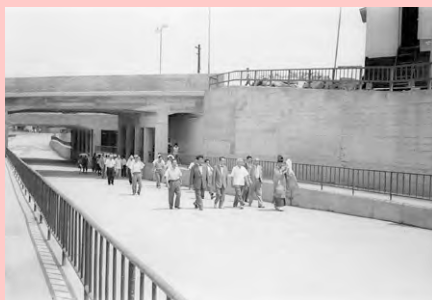
立体交差と中央陸橋完成(昭和36年)
