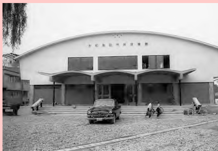
完成した市民体育館(昭和36年)
