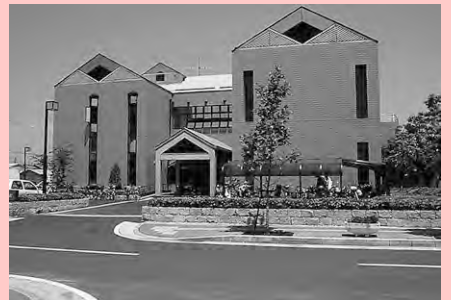
市立図書館新装開館(平成元年)
