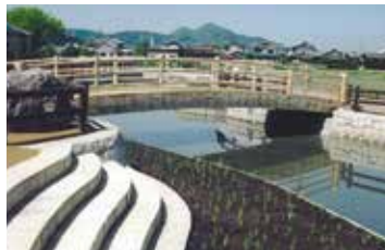
■大和高田市藤森 307 付近
