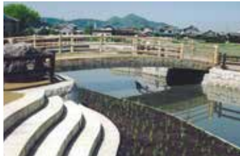
■大和高田市藤森 307 付近
