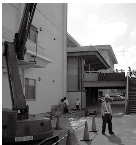
(写真上) 工事中の片塩小学校 (8月22日)
