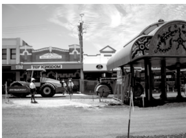
リズモー市内では商店街の道路の整備工事が
