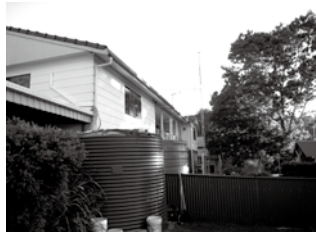
大きな雨水タンク
