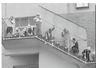
ベランダ手すりのペンキ塗り
