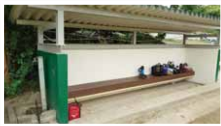
グラウンドベンチに新設された ウッドデッキ
