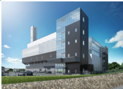
エネルギー回収型廃棄物処理施設： やまと eco クリーンセンター
