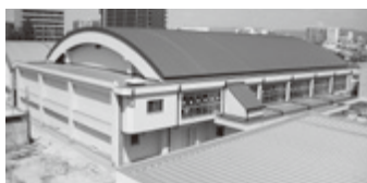
高田中学校体育館
