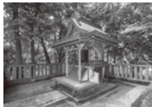
本堂 正面側面(北東より)
