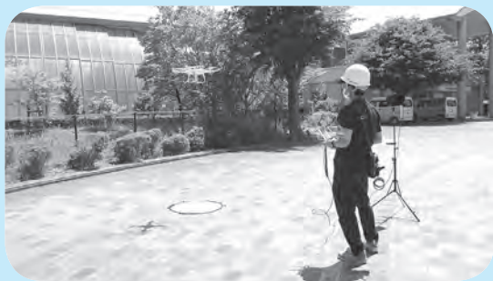
プール棟の屋根の劣化調査をするため、ドローンを操作する様子
