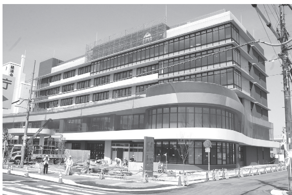
▲建設中の新庁舎(3月17日撮影)
