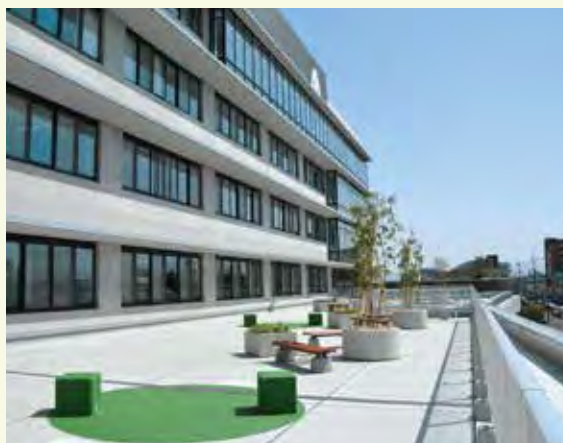
3階 屋外テラス
