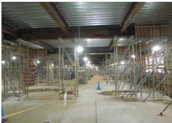
■ 1階柱壁型枠組立、鉄骨梁支保工組立状況
