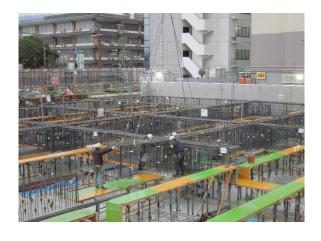
■免震装置上部躯体 鉄筋工事状況
