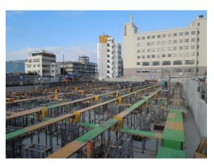
■免震装置上部躯体 型枠工事状況
