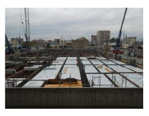
■1階床 デッキ型枠架設状況
