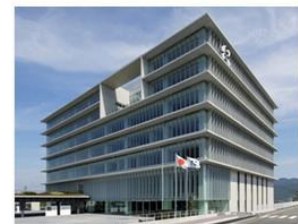
各階の庇により水平ラインを強調した事例／紀の川市庁舎（和歌山県）＊
