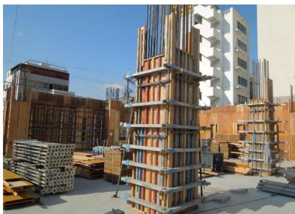
■1階柱型枠工事状況(コラム型枠工法採用)
