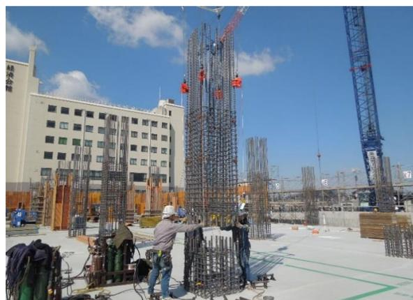
■1階柱鉄筋工事状況(先組柱筋揚重・セット)
