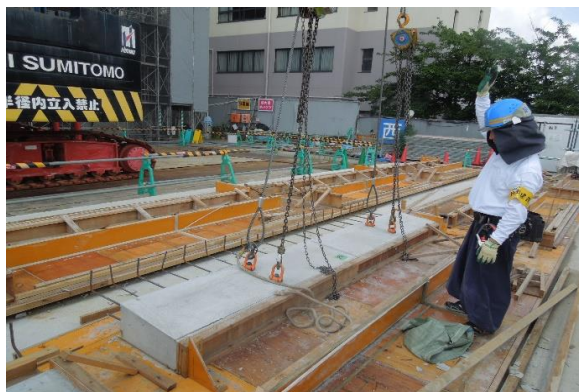
■3階建物外周部底躯体PC揚重状況
