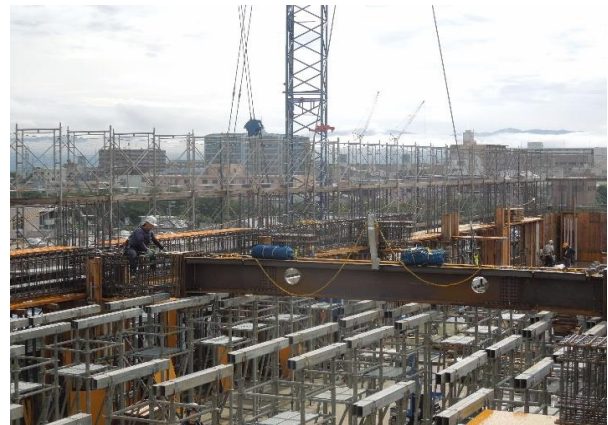
■4階床部分の鉄骨工事状況
