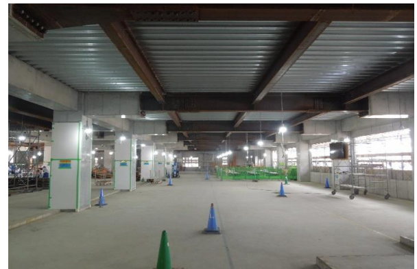
■1階内部仕上工事着手前状況
