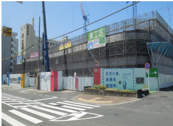
■地上躯体工事の状況
