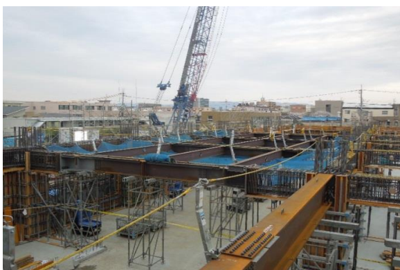
■2階鉄骨梁セット状況
