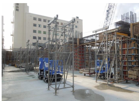
■2階鉄骨梁受け架台組立状況
