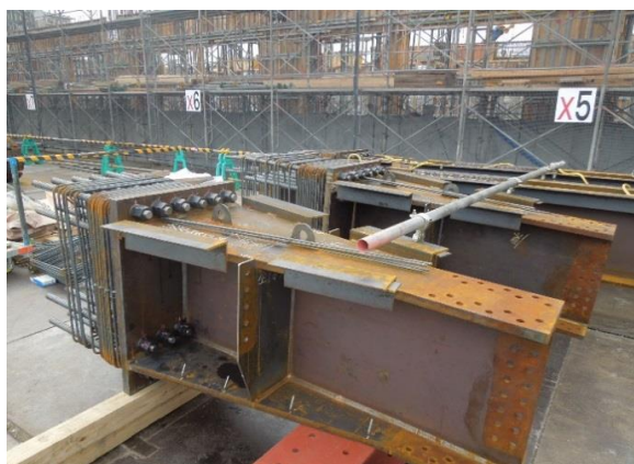
■2階梁鉄骨鉄筋接合部の状況
