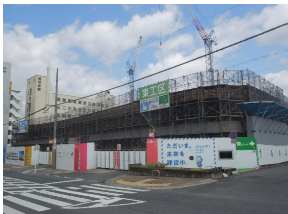
■ 地上躯体工事の状況
