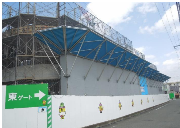
■ 東面外部足場に設置の落下防止設備状況
