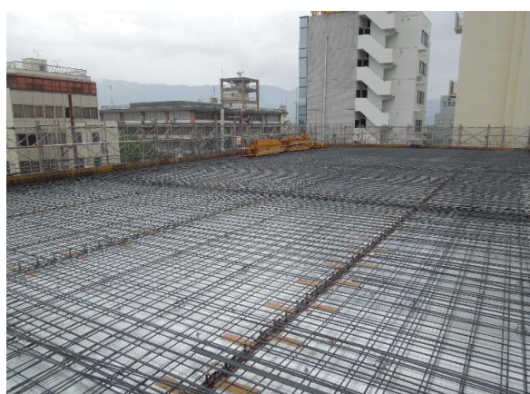
■ 3階屋上部分床配筋工事の状況
