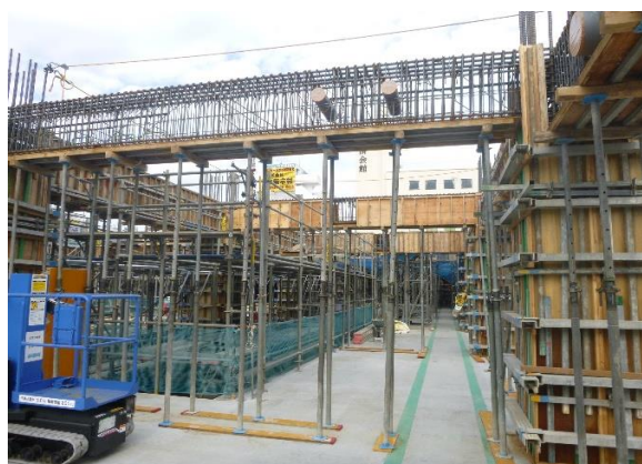
■ 2階柱壁型枠組立、3階梁鉄筋組立状況
