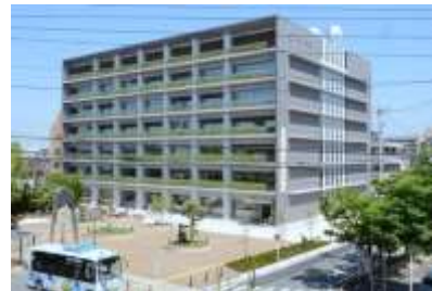
庇・バルコニーと柱によるグリッドで立面を構成した事例 ／みよし市庁舎（愛知県）
