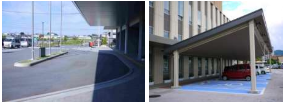
【車が寄り付ける乗降スペース（玉名市庁舎）】 【玄関横の屋根付き駐車場（福島市庁舎）】
