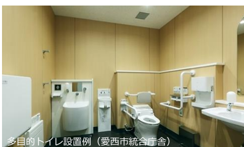
多目的トイレ設置例 (愛西市統合庁舎)
