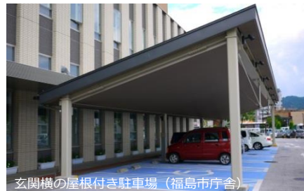
玄関横の屋根付き駐車場（福島市庁舎）
