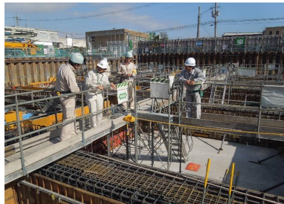
■鉄筋・型枠組立て検査状況
