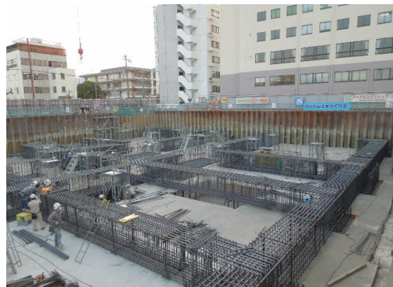
■基礎鉄筋工事状況
