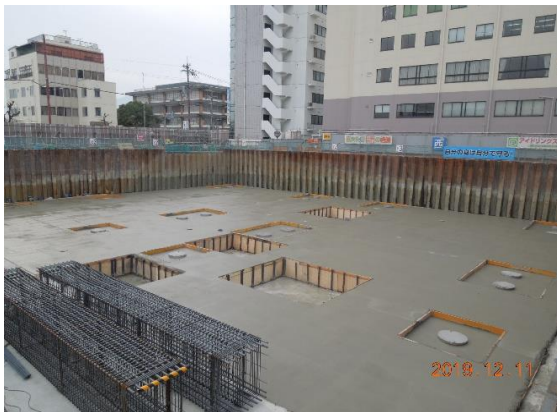
■レベルコンクリート打設完了状況
