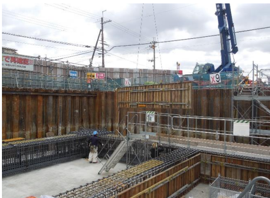
■基礎型枠工事状況
