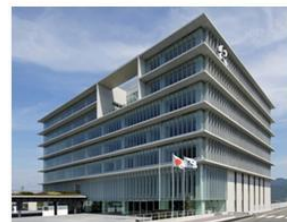
各階の庇により水平ラインを強調した事例／紀の川市庁舎（和歌山県）＊
