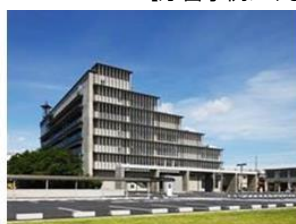
建物ボリュームを段状に工夫した事例 ／木津川市庁舎（京都府）＊
