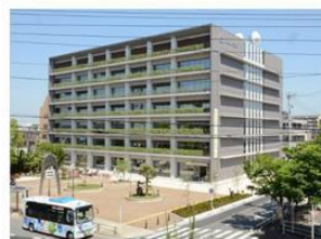
庇（バルコニー）と柱によるグリッドで立面を構成した事例／みよし市庁舎（愛知県）＊
