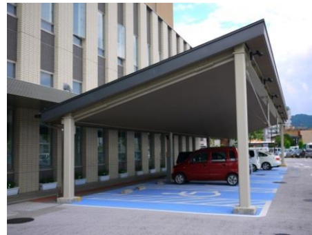
【玄関横の屋根付き駐車場】
