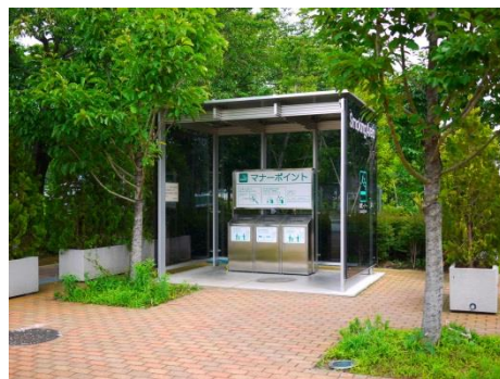
【敷地内の喫煙場所設置例】
