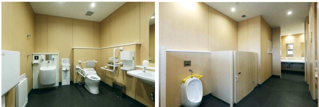
【多目的トイレ・一般トイレ内の子ども用トイレ設置例（愛西市統合庁舎） 2 】
